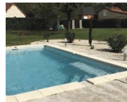
8. Pose des margelles
