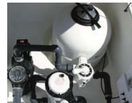
9. Pose du groupe de filtration
