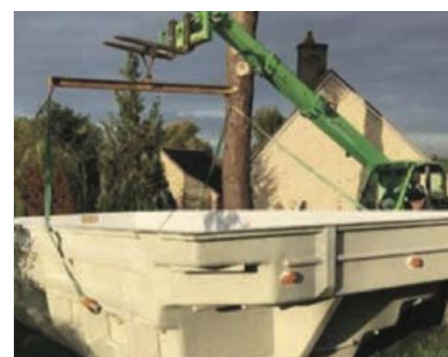
4. Pose en fond de fouille
