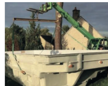
4. Pose en fond de fouille
